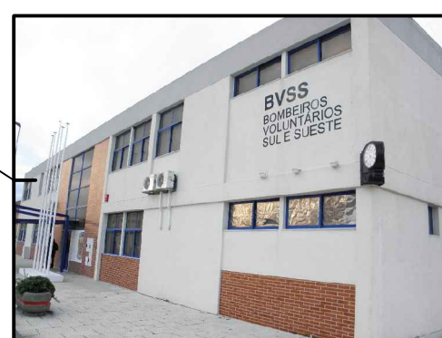
EDIFÍCIO COMANDO BOMBEIRO VOLUNTÁRIOS SUL E SUESTE
