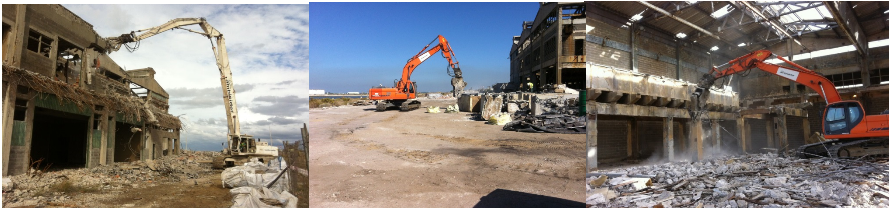
Demolição de edifícios obsoletos
